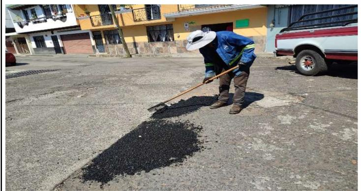
17/01/2025 Bacheo calle Libramiento Oriente Col. Mapeco ZONA ORIENTE 6m3 Mezcla Asfáltica en Caliente 9:02am a 3:30pm
