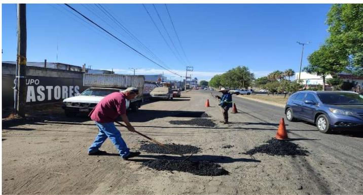
24/02/2025 Bacheo en la calle Libramiento Oriente Col. La Mapeco ZONA ORIENTE 3m3 Mezcla Asfáltica en Fría 9:09am a 2:30pm
