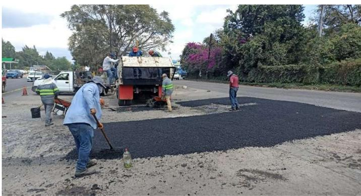
17/01/2025 Bacheo calle Libramiento Oriente Col. Mapeco ZONA ORIENTE 6m3 Mezcla Asfáltica en Caliente 9:02am a 3:30pm
