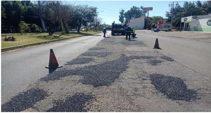
23/01/2025 Bacheo en la calle Libramiento Oriente Col. Quirindavara ZONA ORIENTE 3m3 Mezcla Asfáltica en Caliente 9:42am a 2:30pm
