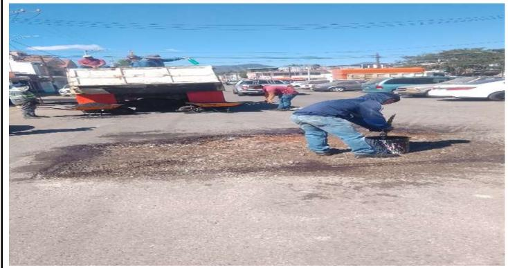
04/02/2025 Bacheo en la calle Paseo de la Revolución Col. Zumpimito ZONA SUR 3m3 Mezcla Asfáltica en Fría 9:07am a 2:57pm
