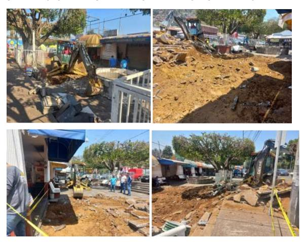
Se realizan trabajos para el cambio de drenaje y de rellenar socavón
