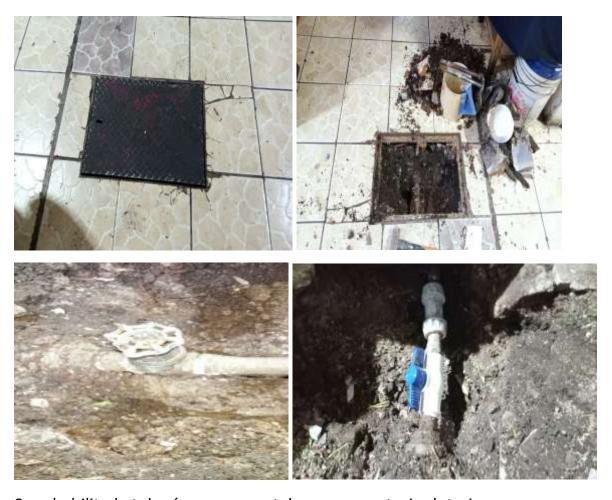
Se rehabilito la tubería que ya contaba con un notorio deterioro
