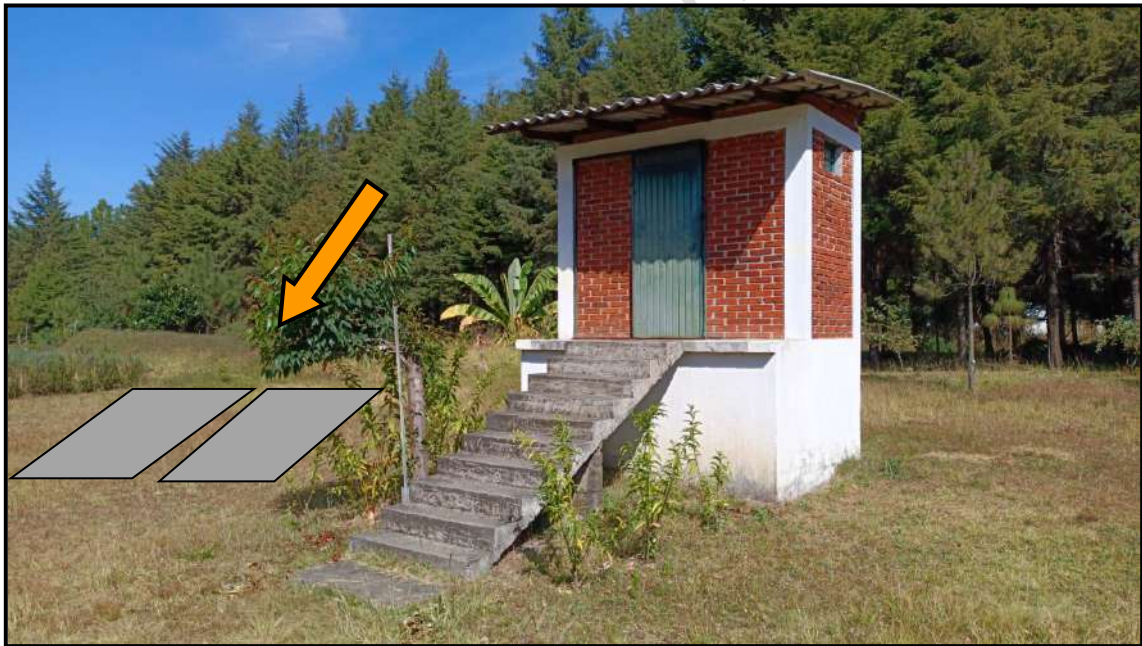
Área en la Sección B donde se construirá baños secos
